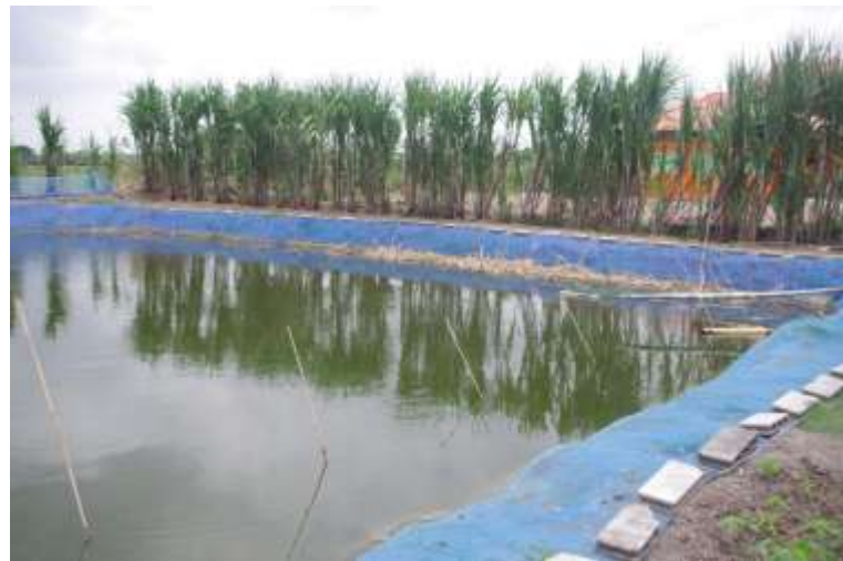
การกั้นคันดินพังจากปลาขุดคุ้ยโดยใช้วอนเขียวและใช้ไม้น้ำปักกันมุงเขียว
